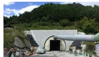
国道371号（新紀見トンネル）
