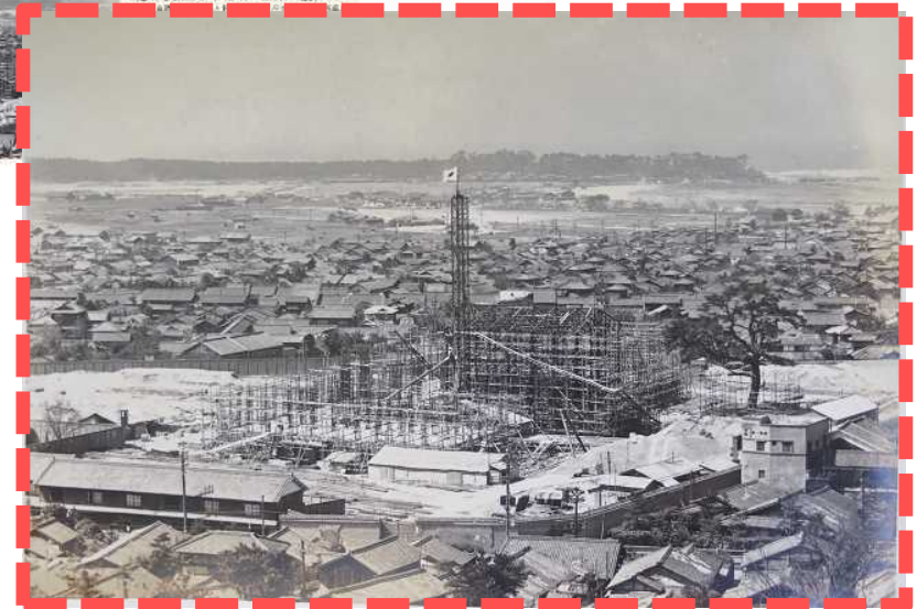
建設中の和歌山県庁舎
